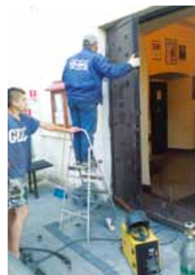
Montaż gotowych drzwi – Turobin, 11 maja 2018 r.
