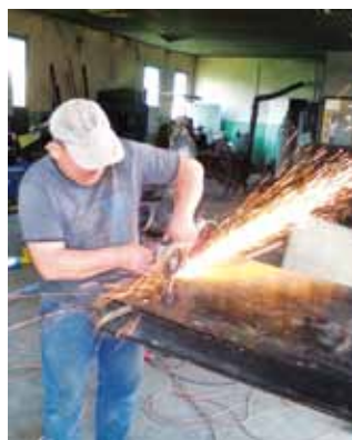
Prace przy skracaniu skrzydła drzwi do zakrystii – 11 maja 2018 r.
