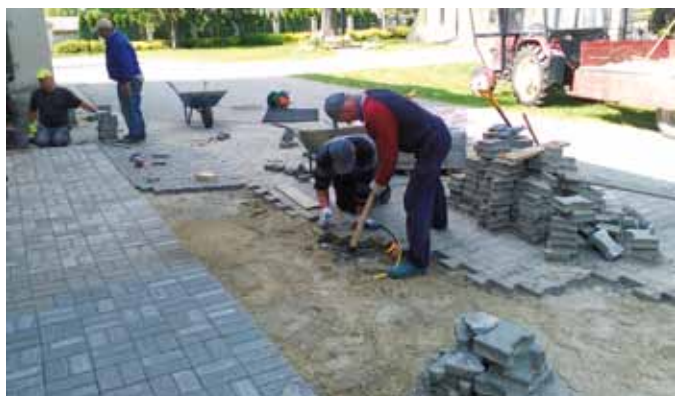
Remont chodnika przy zakrystii
