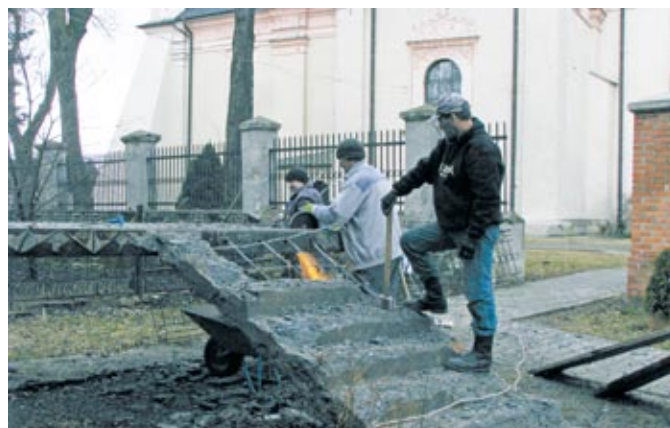
Demontaż zbrojenia starych schodów
