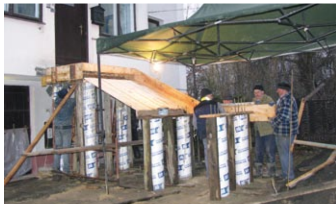
Montaż szalunku konstrukcji nowych schodów
