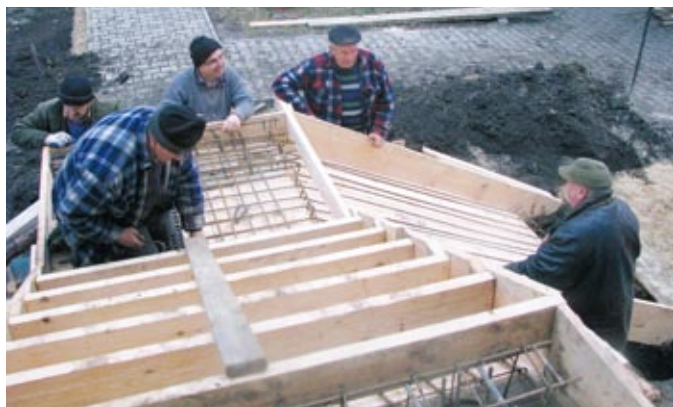
Przygotowanie zbrojenia
