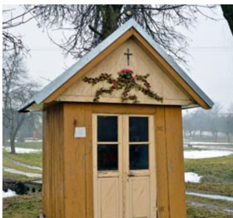
Kapliczka w Olszance przed remontem...
