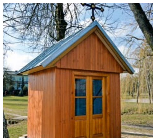
... i po remoncie
