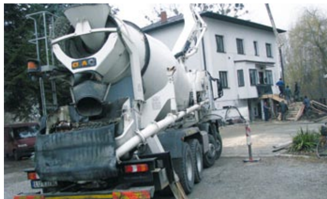
Wylewkę wykonano przy użyciu samochodowej betoniarki – tzw. „gruszki”
