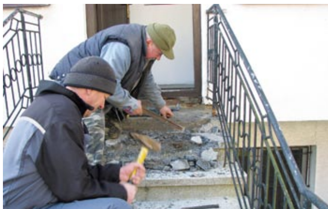
Początek prac – skuwanie lastryko
