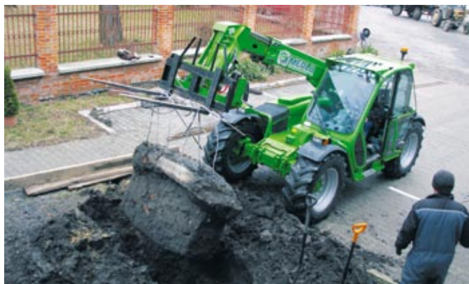
Prace ziemne z użyciem ciężkiego sprzętu
