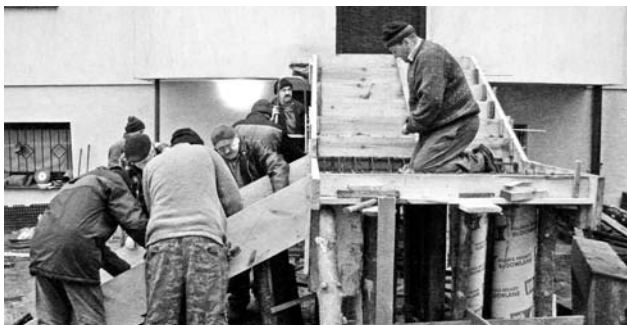
Prace przy szalunku nowych schodów – Turobin, 9 marca 2017 r.
