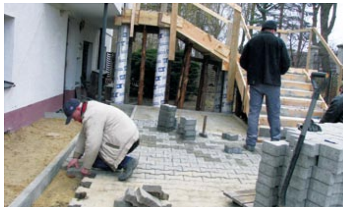
Układanie kostki przy nowej plebanii
