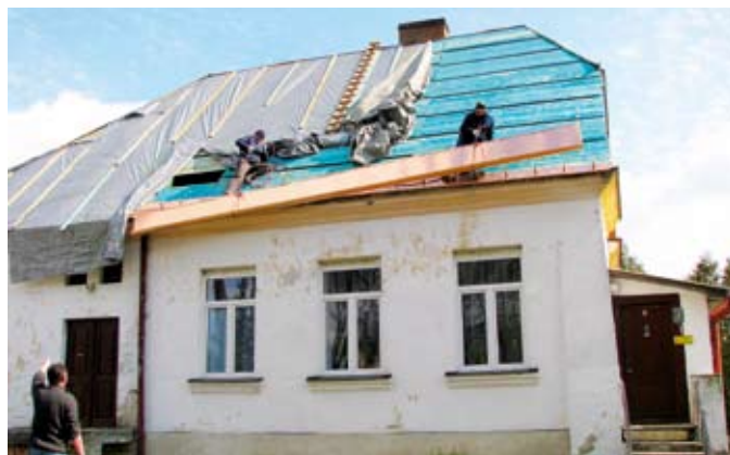
Dalsza część prac przy wymianie dachu na starej plebanii od strony zachodniej
