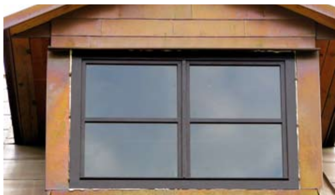
Nowe okno wstawione w budynku starej plebanii
