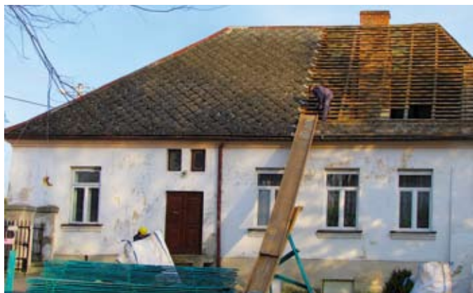
Demontaż starego poszycia dachu na plebanii – 17 marca 2016 r.
