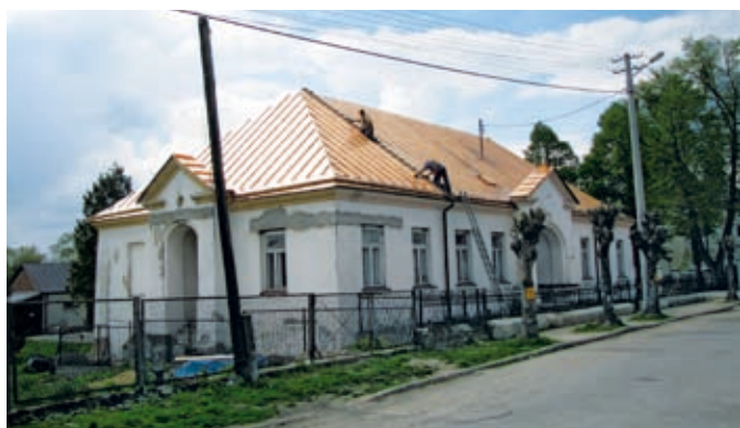
Wymiana poszycia dachowego prawie zakończona – 30 kwietnia 2014 r.
