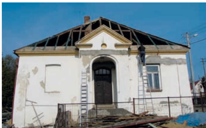
Pozostała jeszcze ściana wschodnia
