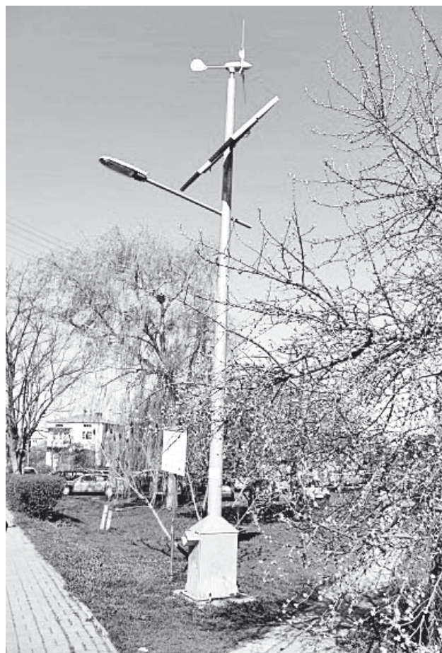
Jedna z lamp zasilanych energią wiatrową i słoneczną
