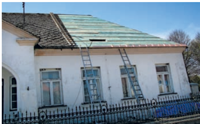
Usuwanie starego pokrycia dachowego, Turobin – 2 kwietnia 2014 r.
