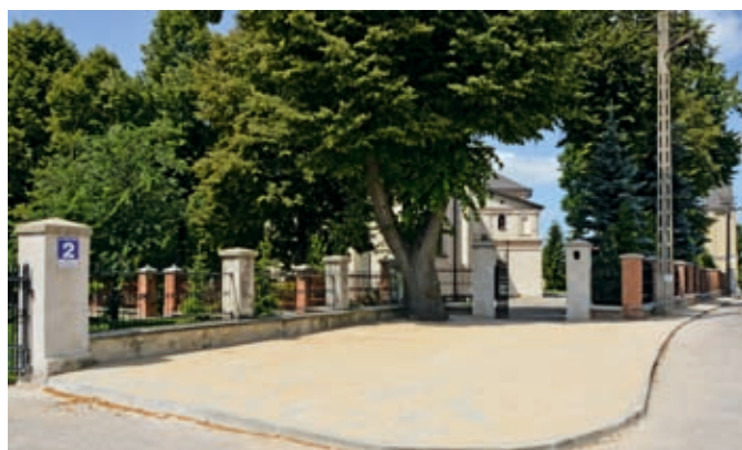
Nowy chodnik przy kościele św. Dominika wykonany przez gminę w Turobinie
