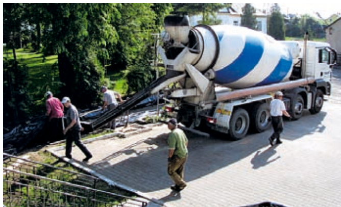
Wylewka fundamentu
