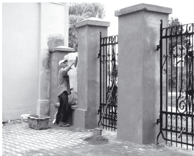
Prace wykończeniowe przy bramie głównej kościoła parafialnego – Turobin – 4 czerwca 2013 r.
