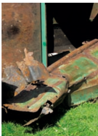
Zniszczone elementy podłogi
