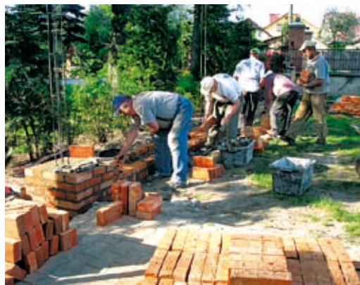
Prace przy ogrodzeniu przebiegały sprawnie
