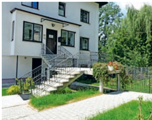
Przebudowane przejście z parkingu przy plebanii do kościoła
