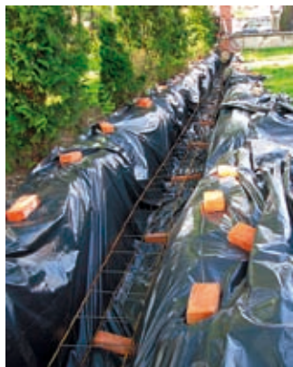
Zbrojenie pod nowy fundament
