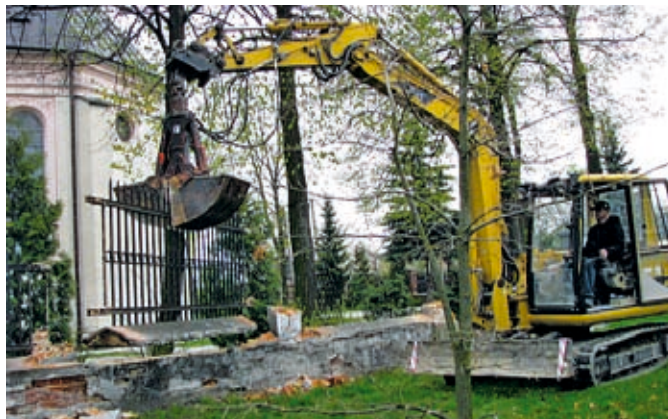
Początek prac rozbiórkowych
