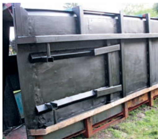
Kontener pod koniec remontu – wymieniona cała podłoga – Turobin, 9 lipca 2013 r.
