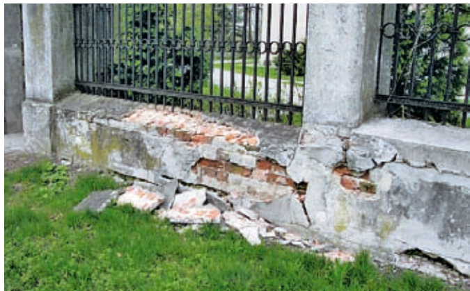
Ogrodzenie kościoła przed remontem
