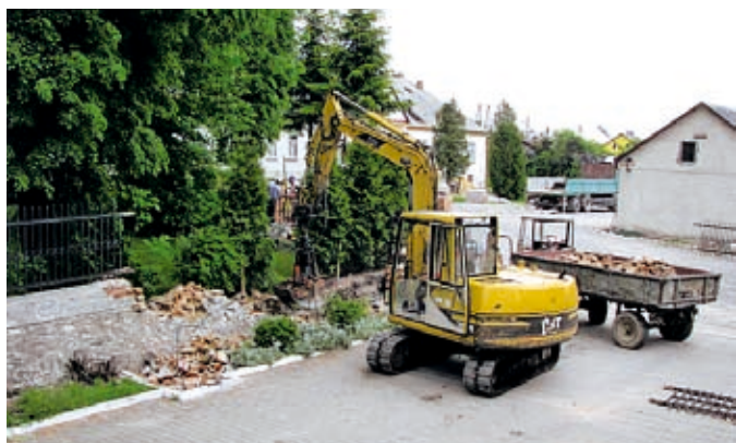
Dalszy ciąg prac od strony plebanii
