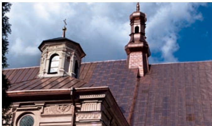
NOWY DACH POKRYTY BLACHĄ MIEDZIANĄ NA KOŚCIELE ŚW. DOMINIKA W TUROBINIE – 30 WRZEŚNIA 2007 r.
