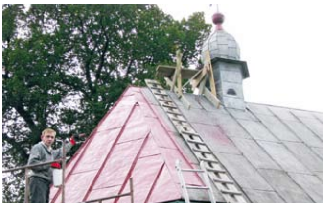
Malowanie dachu na kaplicy św. Elżbiety
