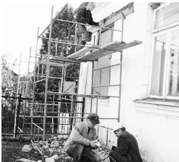
Prace wzmacniające budynek starej plebanii
