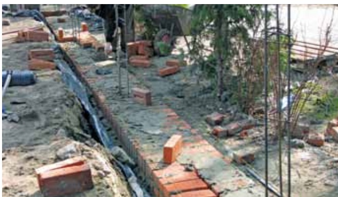
Prace przy budowie nowego parkanu
