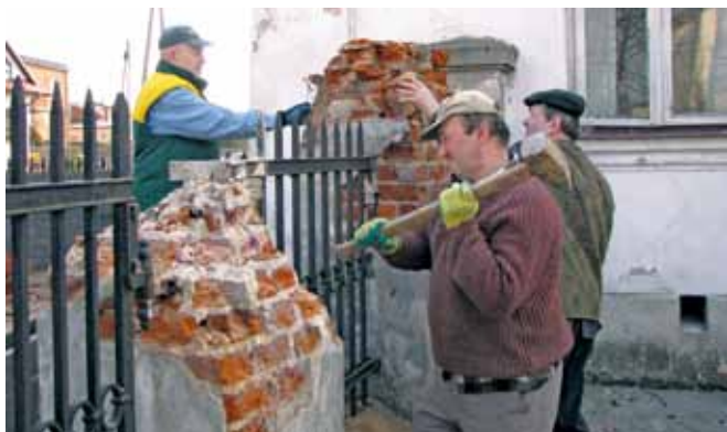
Rozbiórka starego parkanu – Turobin – 19.03.2012 r.
