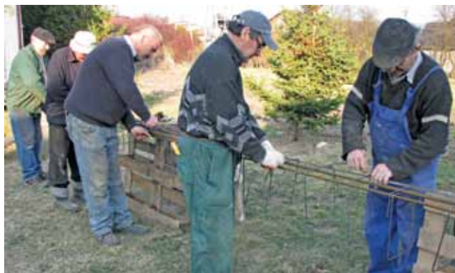
Prace przy konstrukcji zbrojenia
