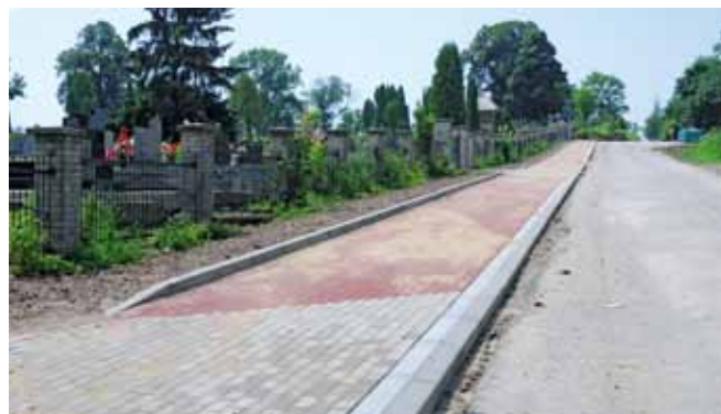
Nowy chodnik przy cmentarzu w Turobinie wykonany w czasie remontu drogi gminnej
