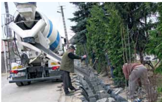
Do wypełnienia fundamentu użyto specjalistycznego sprzętu – 28.03.2012 r.
