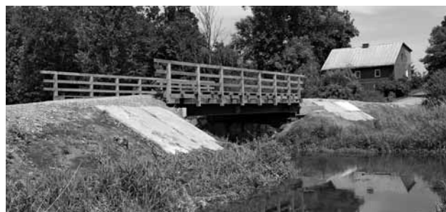
Wyremontowany most drogowy na rzece Por w Czernięcinie Poduchownym
