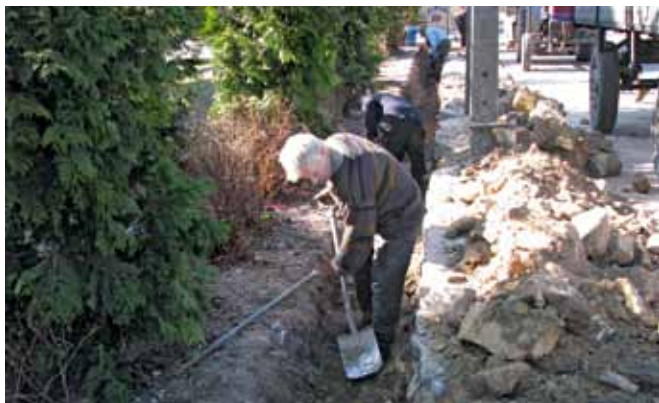
Przygotowanie terenu pod nowy fundament
