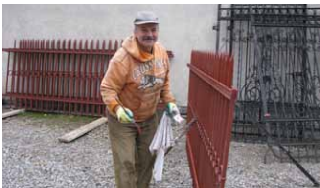
Prześla po piaskowaniu trzeba pokryć farbą podkładową – 16.04.2012 r.
