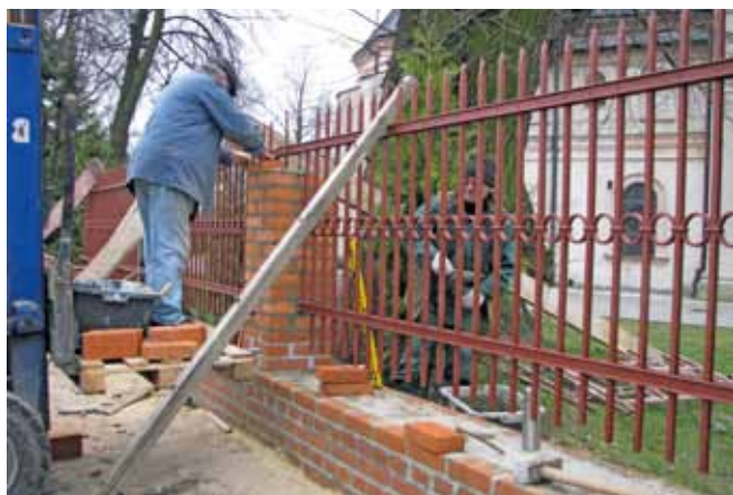
Prace przy parkanie posuwają się do przodu – Turobin 17.04.2012 r.
