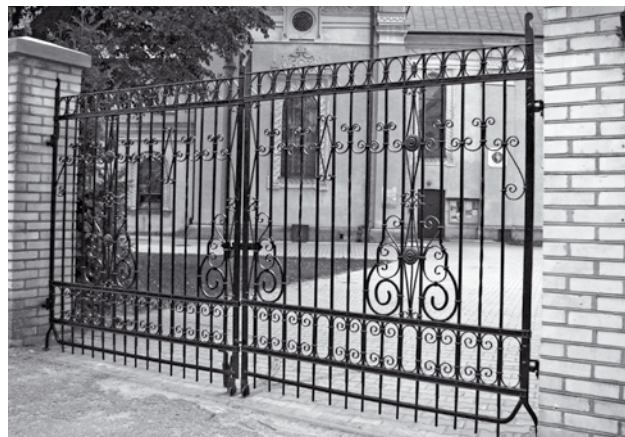
Główna brama po remoncie i malowaniu przed kościołem św. Dominika w Turobinie
