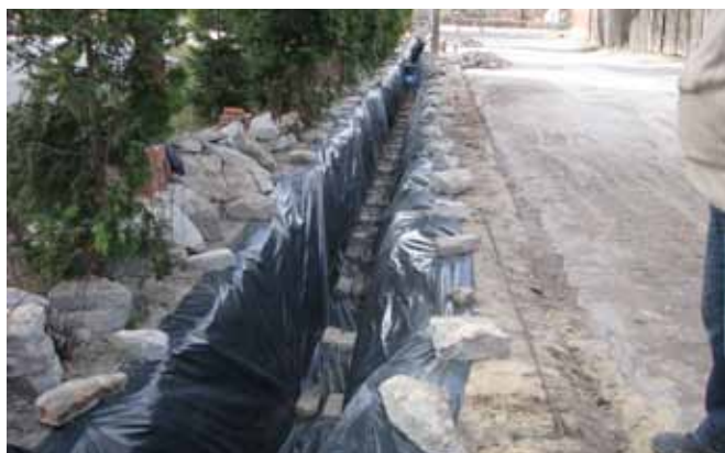
Właściwa izolacja i zbrojenia przed zalaniem nowego fundamentu
