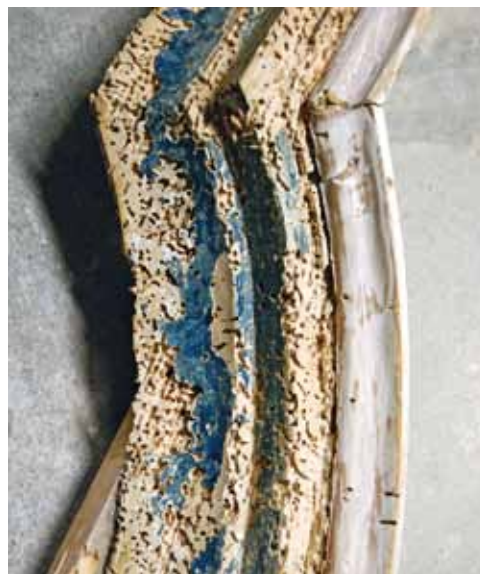
Po zdjęciu farby widoczne zniszczenia drewna przez drewnojady
