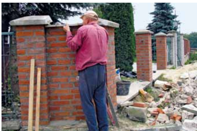
Prace przy ogrodzeniu kaplicy w Hucie Turobińskiej
