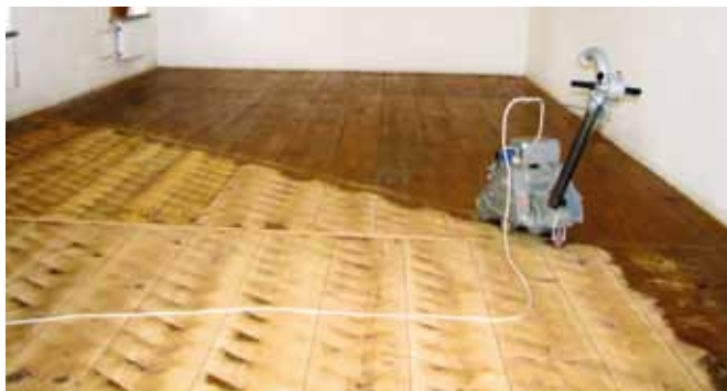
Prace cykliniarskie na nowej plebanii – wrzesień 2011 r. – pierwsze od 1978 r.
