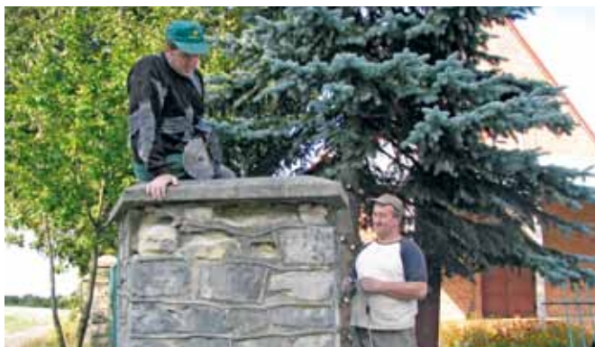
Huta – rozbiórka starego słupa przy kaplicy – wrzesień 2011 r.
