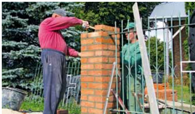
Murowanie nowych słupów ogrodzenia przy kaplicy
