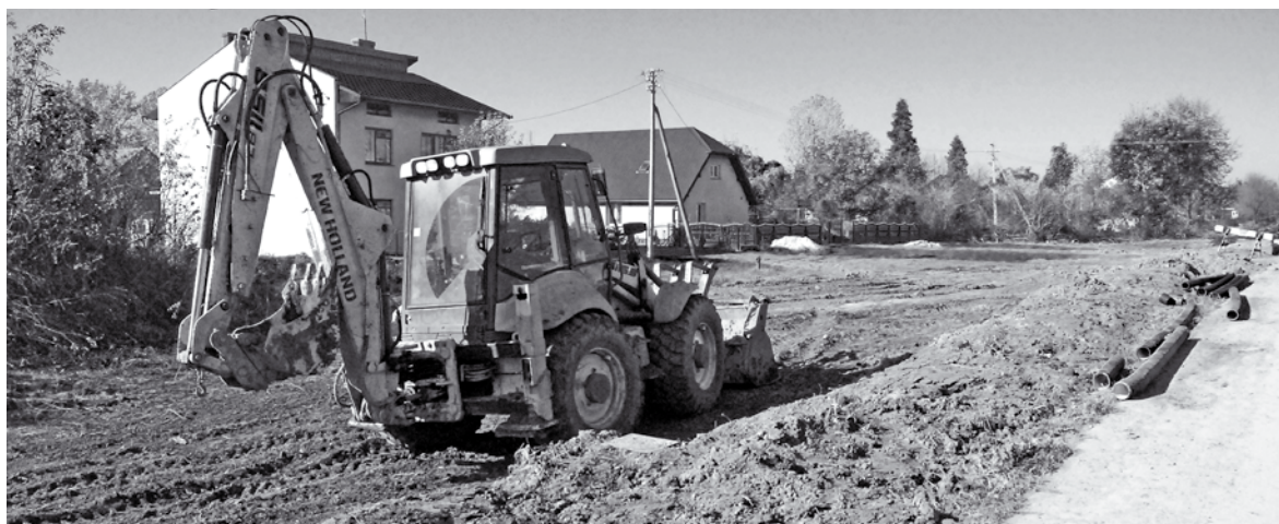
Kanalizacja ruszyła od miejscowości Przedmieście
