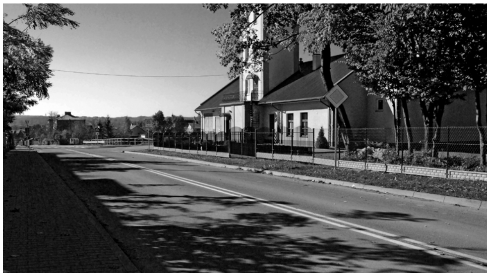
Początek nowej drogi przy ulicy Piłsudskiego – w głębi remiza OSP
