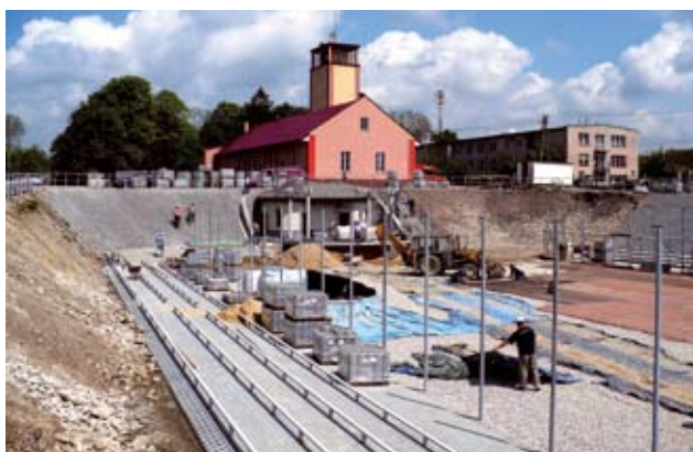
Dalsze prace brukarskie przy podłożu
