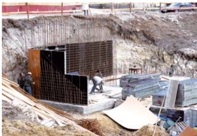
Usuwanie szalunków i zbrojenie ściany oporowej zaplecza
