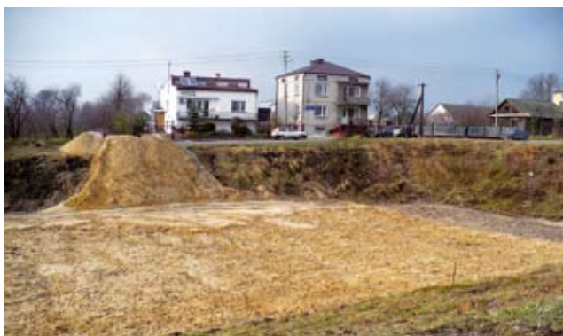
Pierwsza warstwa podłoża przepuszczalnego
