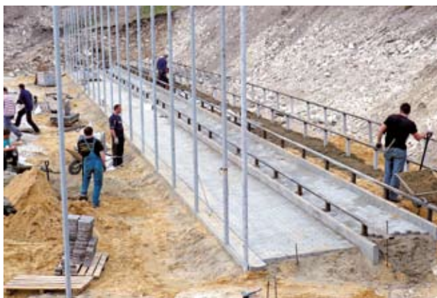
Prace brukarskie przy trybunie wschodniej
