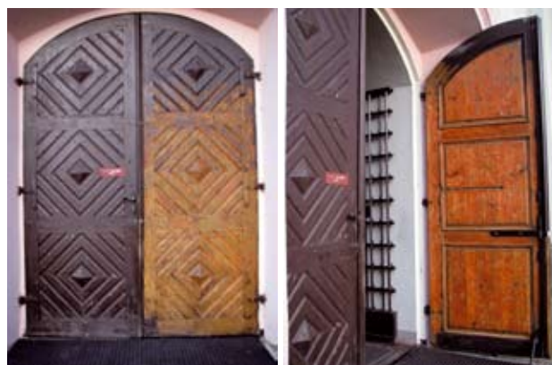
Renowacja drzwi głównych przy kościele Św. Dominika – lipiec 2010 r.
