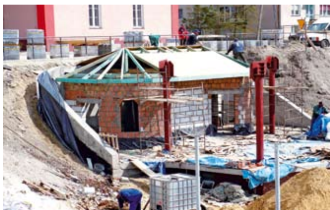
Prace ciesielskie przy zadaszeniu zaplecza
