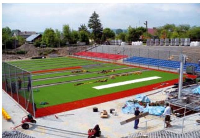
Kolejne prace wykończeniowe
