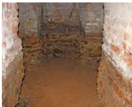
PUSTKA PO WYWIEZIENIU GRUZU Z DZWONNICY
