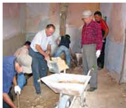
ROZBIÓRKA POSADZKI W KOSTNICY
