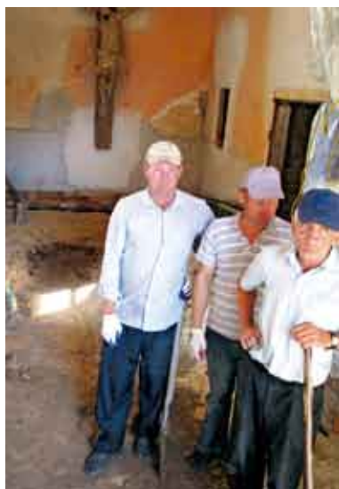
PRACE PRZY OBNIŻANIU POSADZKI
