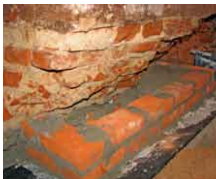
PODMUROWANY FUNDAMENT WE WNĘTRZU DZWONNICY
