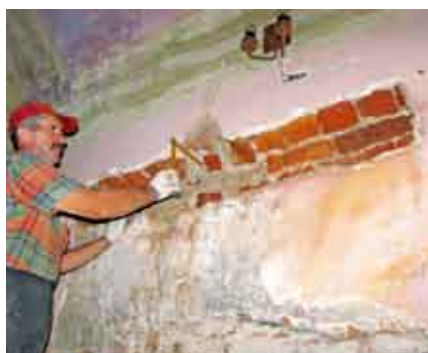
BRUZDA WYKUTA W PĘKNIĘTEJ ŚCIANIE – MIEJSCE NA WSTAWIENIE NADPROŻA
