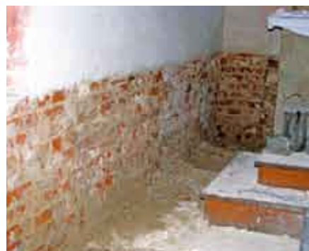
USUWANIE ZAWILGOCONYCH TYNKÓW W KOSTNICY
