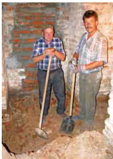
USUWANIE GRUZU Z WNĘTRZA DZWONNICY
