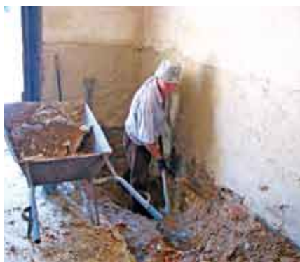
ODKRYWANIE FUNDAMENTÓW KOSTNICY
