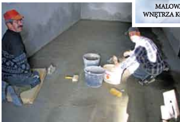
WYLEWKA BETONOWA
