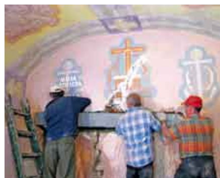
MONTAŻ NADPROŻA WZMACNIAJĄCEGO PĘKNIĘTĄ ŚCIANĘ
