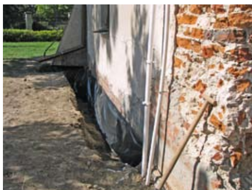
OSUSZANIE FUNDAMENTÓW OD ZEWNĄTRZ
