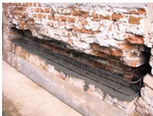
WZMOCNIENIA ŚCIANY ZACHODNIEJ
