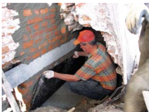
NOWE FUNDAMENTY NAROŻNIKA PRZED ROZEBRANIEM PRZYPORY
