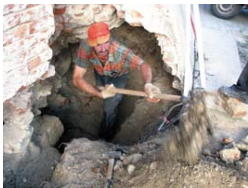
WYKOPY POD FUNDAMENT NAROŻNIKA PRZED ROZEBRANIEM PRZYPORY
