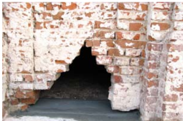
NOWE FUNDAMENTY OD STRONY ULICY
