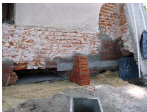
WYMIANA FUNDAMENTÓW MIĘDZY PRZYPORAMI OD STRONY POŁUDNIOWEJ
