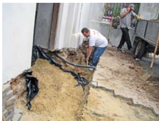
PRZYGOTOWYWANIE NOWEGO WEJŚCIA DO DZWONNICY
