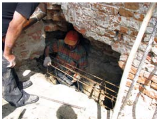
ZBROJENIA FUNDAMENTÓW OBOK POZOSTAWIONEJ PRZYPORY
