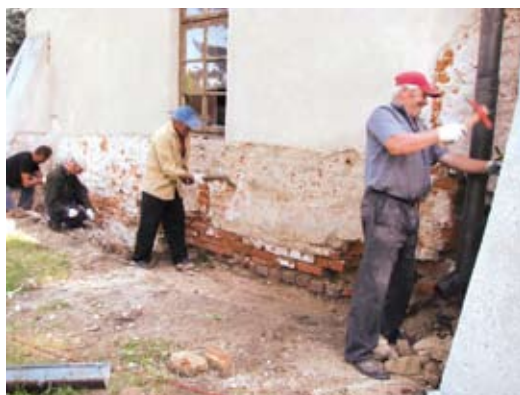
SKUWANIE TYNKÓW ZEWNĘTRZNYCH
