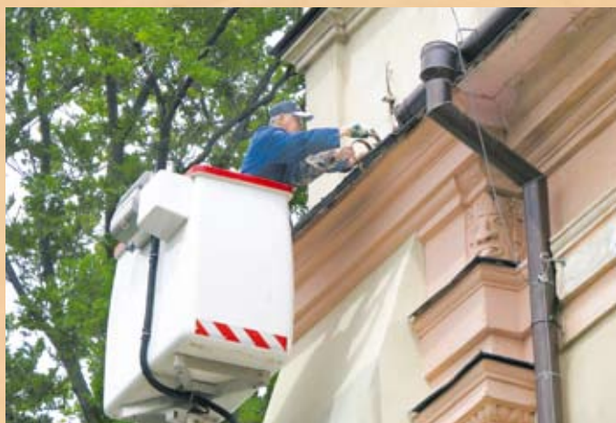
Montaż rynajzy nad przyporą kościoła
