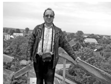
Ks. Dziekan nadzoruje prace na dzwonnicy
