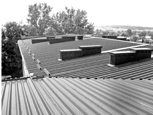
Nowy dach na szkole w Turobinie
