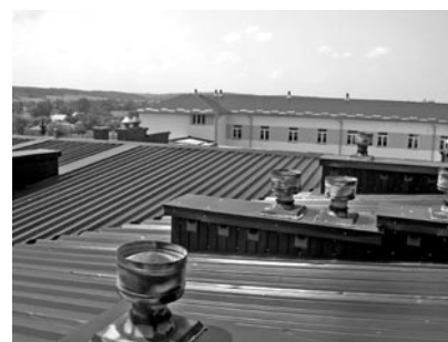
Prace zostały przeprowadzone sprawnie i solidnie
