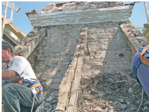
Dzwonnica – po zdjęciu starej blachy i desek
