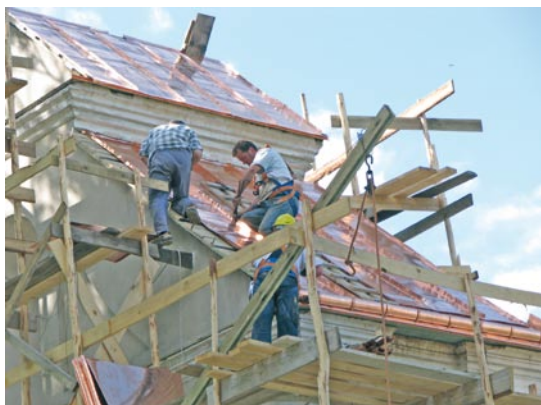
Montaż blachy miedzianej
