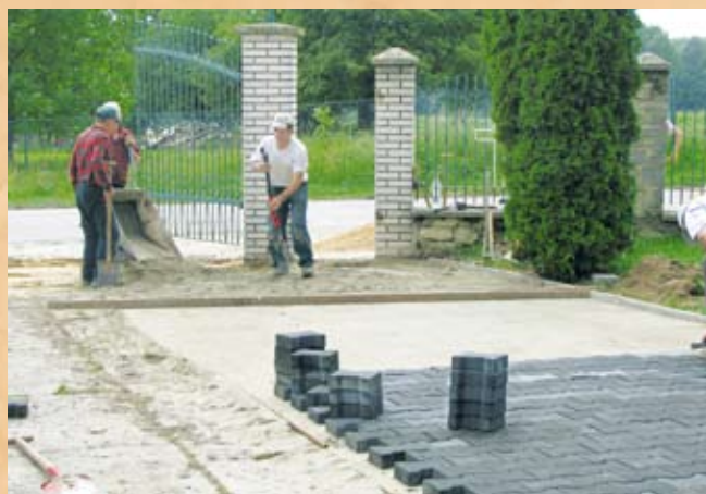
Układanie chodnika przed kaplicą
