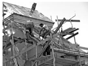
Montaż nowej blachy miedzianej na dzwonnicy w Turobinie
