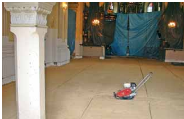
Przygotowane podłoże pod wylewkę cementową
