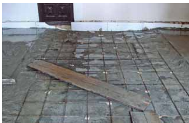
Papa, zbrojenie i wylewka cementowa o grubości 50 cm
