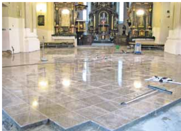
Roboty w kościele przebiegają sprawnie
