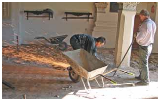
Demontaż zbrojenia starej posadzki
