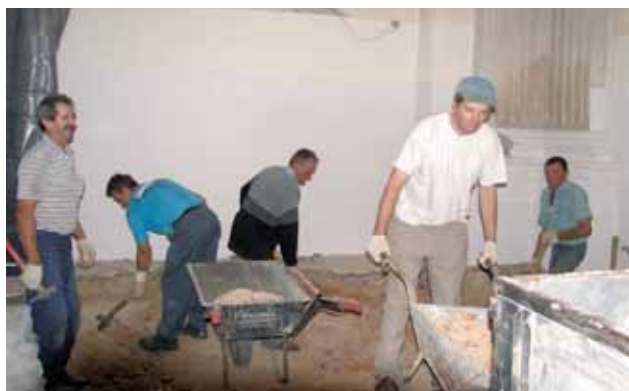
Prace w kaplicy Matki Bożej – głębokość wykopu 80 cm – 1 m
