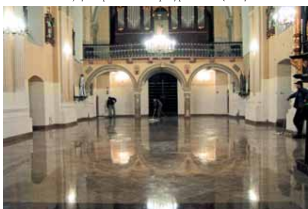
Końcowe prace przy posadzce – użycie specjalnych preparatów konserwujących
