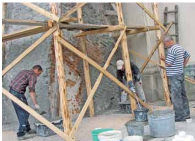
Tynkowanie przypory zewnętrznej
