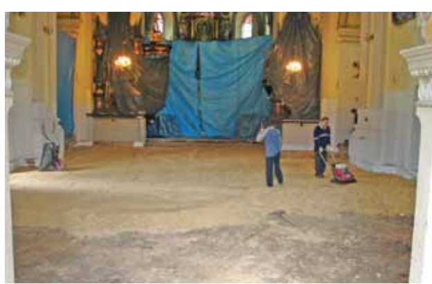
Kolejny etap prac z użyciem zagęszczarki
