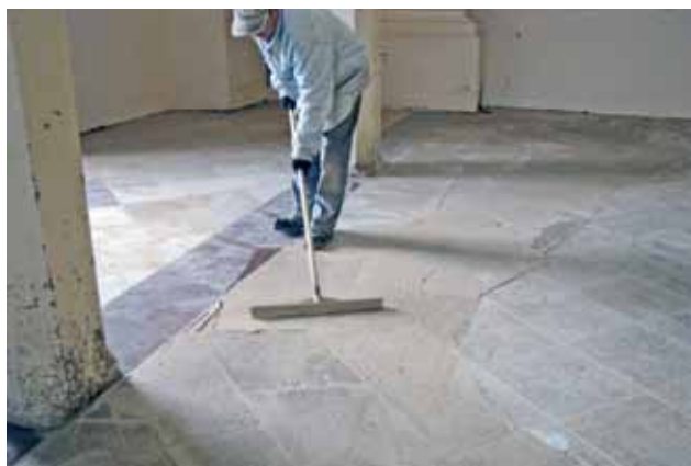
Fugowanie nowej posadzki
