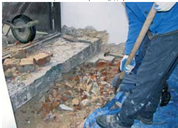
Demontaż starych schodów w zakrystii
