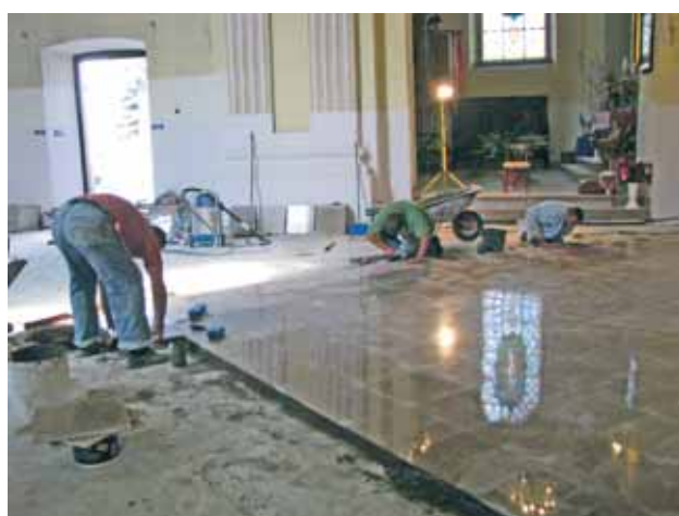
Dalsze prace – widoczny odbijający się witraż w nowej posadzce
