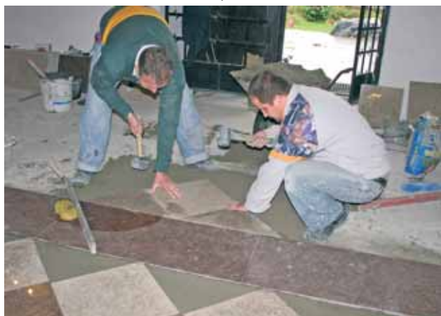
Dochodzimy do głównego wejścia
