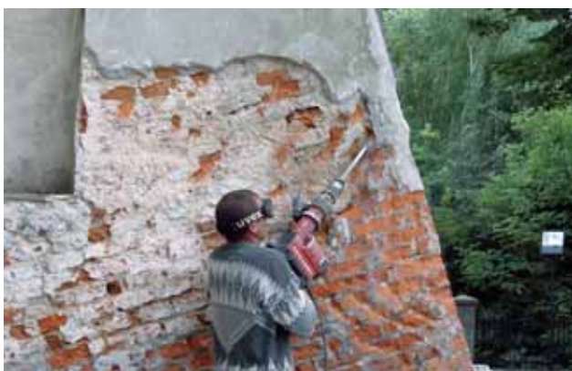
Skuwanie starej elewacji z przypór zewnętrznych kościoła
