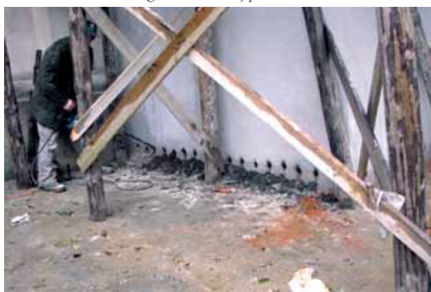
Kolejny etap osuszania przypór zewnętrznych
