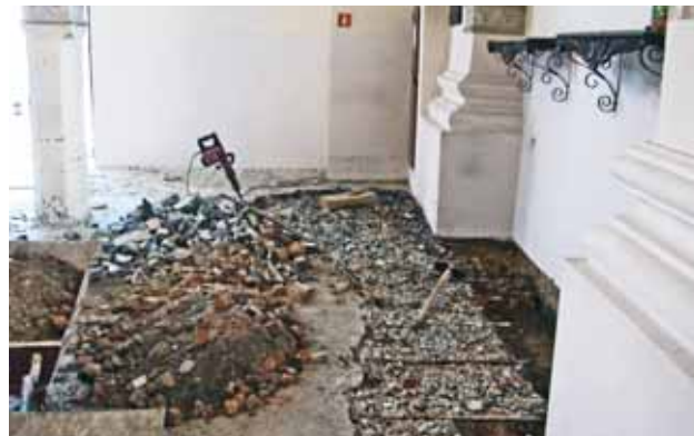
W użyciu młot udarowy przy usuwaniu starej posadzki
