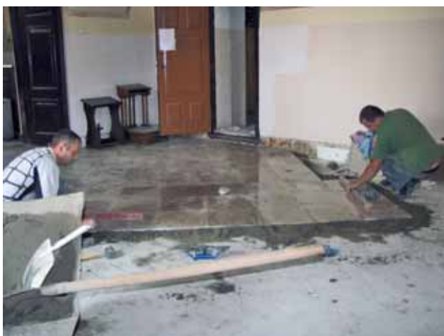
Rozpoczęcie układania posadzki w zakrystii
