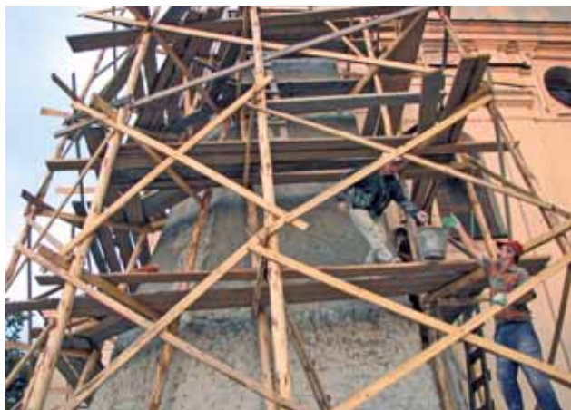
Prace na wysokościach
