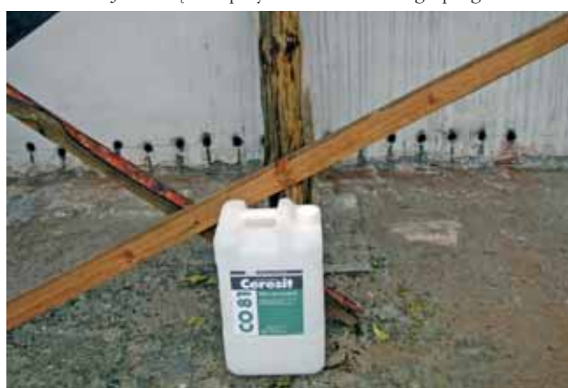
Specjalny preparat zabezpieczający przed wilgocią przypory zewnętrzne
