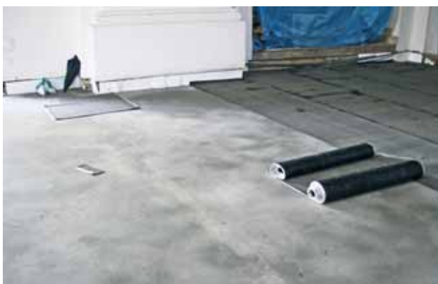
Warstwa izolacyjna – układanie papy
