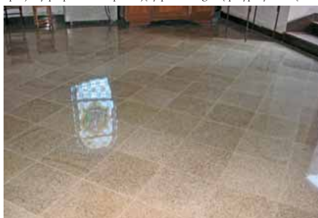
Nowa posadzka w zakrystii
