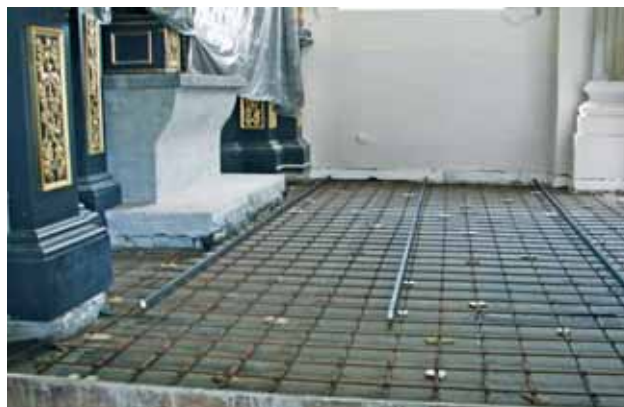
Gotowe zbrojenie – kaplica Matki Bożej
