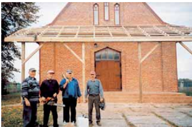
Nowe zadaszenie w kaplicy św. Anny w Hucie. Początek października 2007 r.
