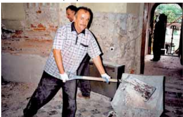
Przy zbijaniu tynków w kościele św. Dominika w Turobinie – 20.08.2007 r.
