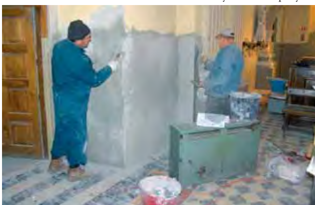
Tynkowanie ścian po uprzednim osuszeniu w kościele parafialnym
