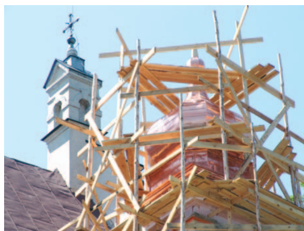
Wieżyczka już prawie gotowa
