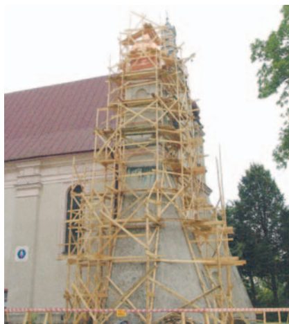
Rusztowania stoją. Wymiana dachu rozpoczęta
