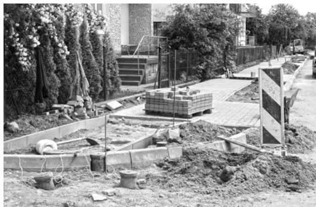
W trakcie dalszych robót na ul. Szczepieszkiej w Turobinie
