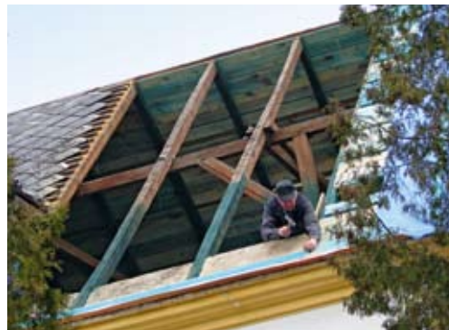
Początek prac przy wymianie dachu na budynku starej plebanii od strony południowej
