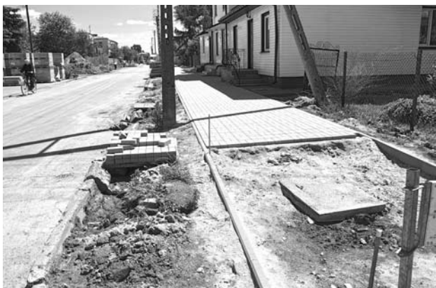
Przebudowa drogi gminnej w Turobinie, ul. Szczepieszka
