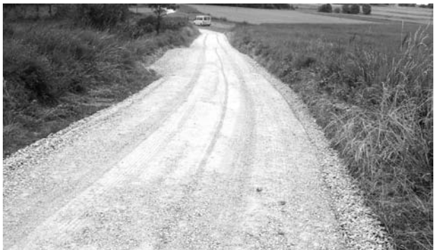
Droga po remoncie
