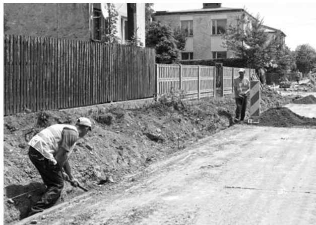
Prace przygotowawcze do położenia krawężników, Turobin, ul. Szczepieszka
