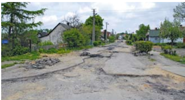
Prace przy kanalizacji – przygotowania do położenia asfaltu.
