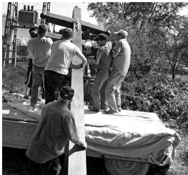
Za chwilę nowy krzyż stanie na swoim miejscu – Żabno 21.05.2011 r.
