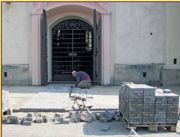
Prace przy nowym chodniku przed wejściem do kościoła – 31.03.2011 r.
