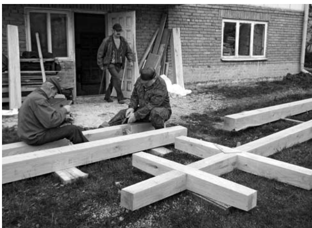
W trakcie prac montażowych przy nowych krzyżach – Żabno 05.05.2011 r.
