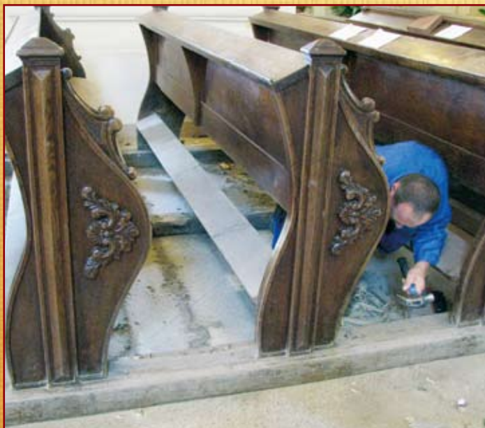
Po demontażu starej podłogi
