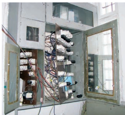
Stara tablica rozdzielcza podczas demontażu – 25.02.2011 r.
