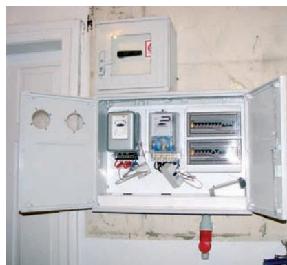
Prace dobiegają końca – nowa tablica rozdzielcza – 10.03.2011 r.
