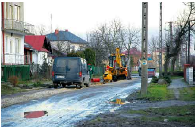
Kanalizacja ulicy Szczepieskiej w Turobinie
