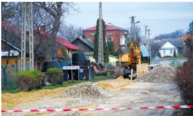
Prace przy kanalizacji – Turobin, ul. Staszica
