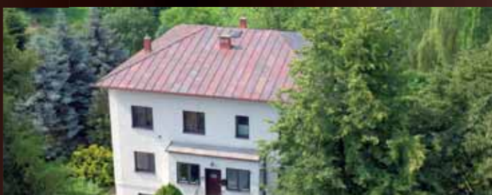
Nowy dach na budynku plebanii w Turobinie
