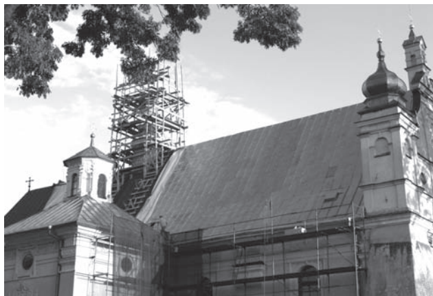
Wymiana blachy na wieży głównej
