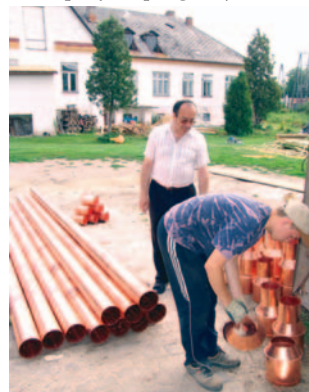
Ksiądz Dziekan nadzoruje prace
