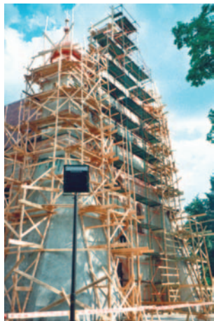
Rusztowania przy wejściu głównym
