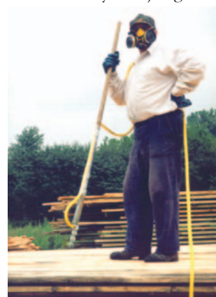
Prace przy impregnacji drewna
