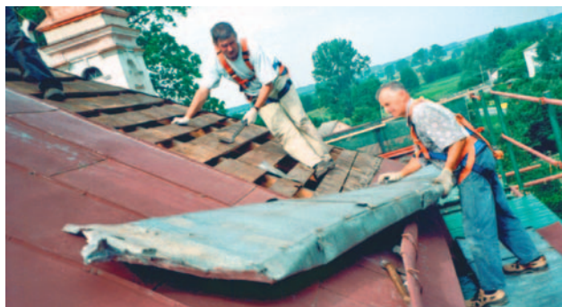
Usuwanie starej blachy
