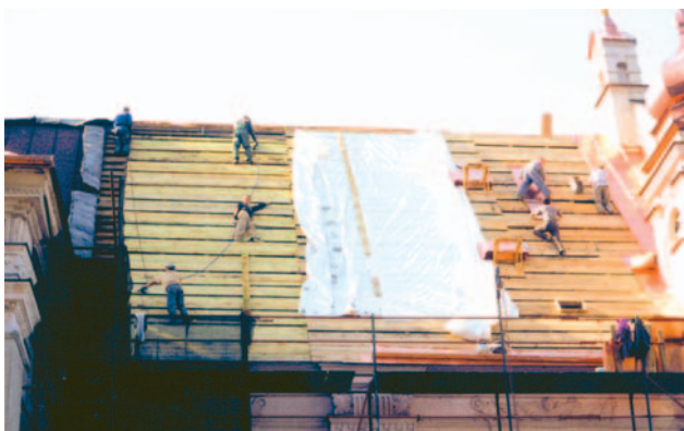
Prace przebiegały szybko
