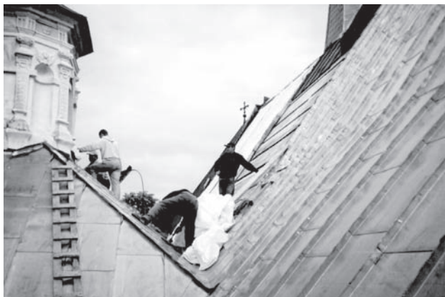
Prace na dachu kościoła od strony kaplicy św. Anny
