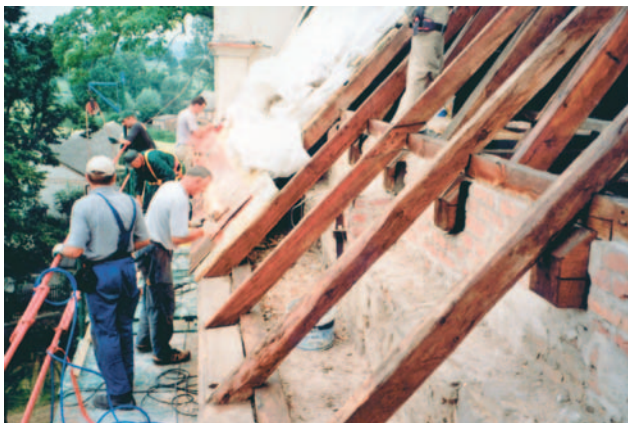
Prace przy wymianie więźby dachowej od strony plebanii
