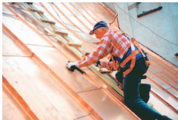
Prace blacharskie wykonała firma rodzinna z Bełżyc pod kierunkiem mistrza Karola Kamińskiego
